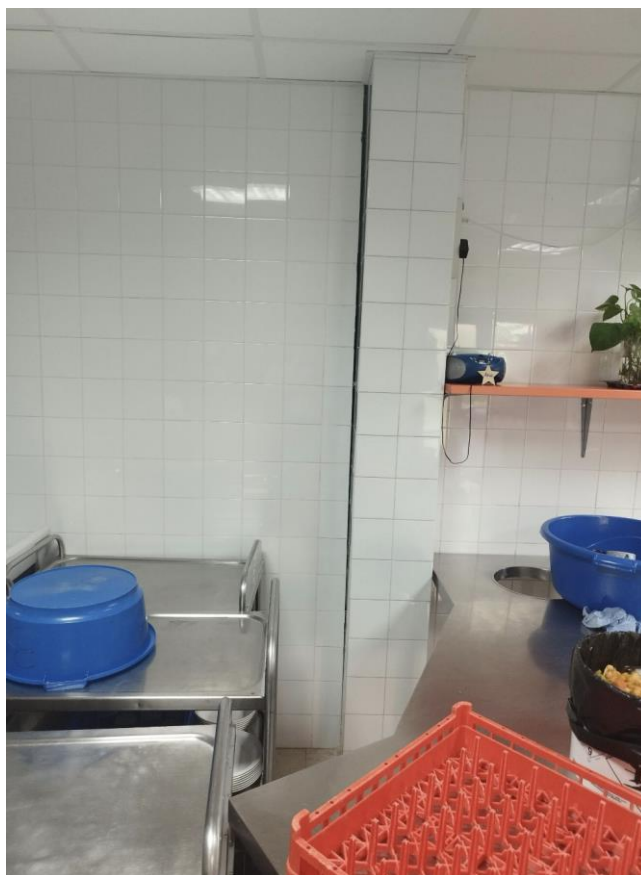
Figura 8. Abertura en el encuentro entre tabique y soporte
