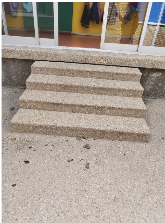
Figura 9. Descenso relativo entre la escalera y el forjado de planta baja
