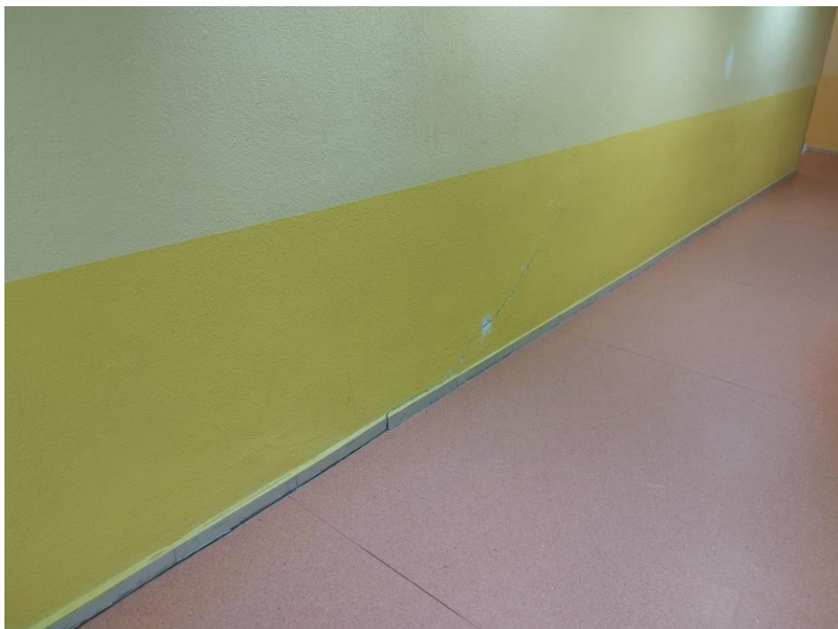
Figura 7. Fisuración de trazado inclinado en la tabiquería del edificio
