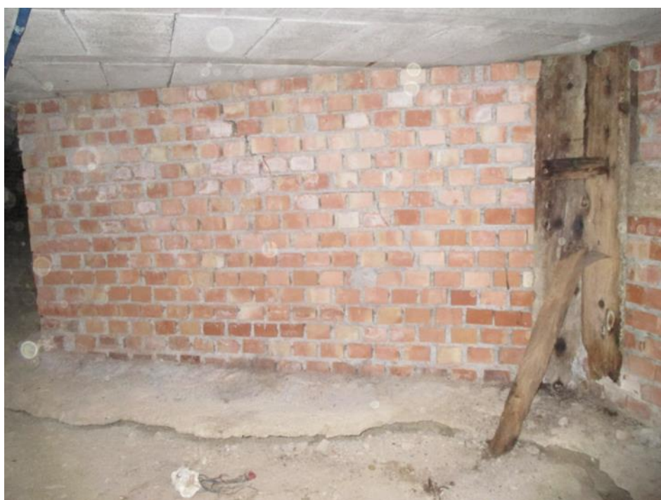
Figura 10. Fisuración en un murete de apoyo del forjado sanitario. Obsérvese también el cedimiento del terreno, provocando el despegue del hormigón de la zapata corrida de apoyo que quedó derramado sobre el terreno en el hormigonado original de la zanja
