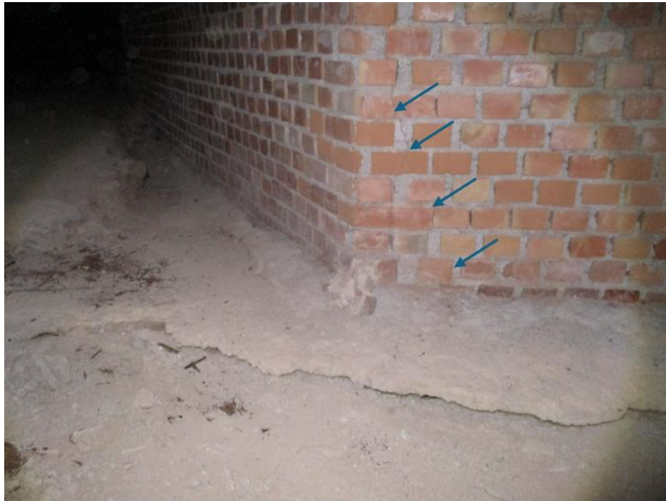
Figura 11. Vistas de la fisura en encuentro entre muretes de apoyo del forjado sanitario. Véase también en este caso el cedimiento del terreno
