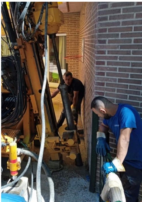
Figura 25. Ejecución del sondeo inclinado S-3
