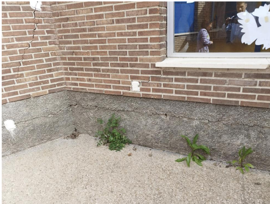
Figura 6. Fisuras en el cerramiento de uno de los patios interiores
